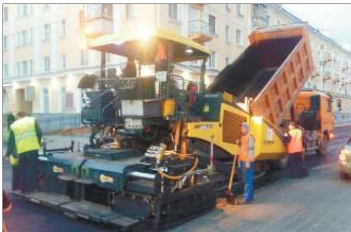
**На ул. Карла Маркса идут работы по укладке нижнего выравнивающего слоя асфальта**
