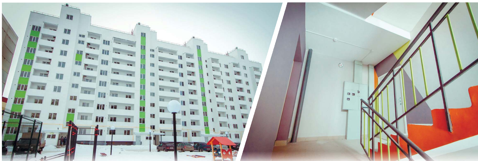
Бывший проблемный дом №34 на бульваре Знаний, помимо реализации проекта, получил от нового застройщика озеленение и благоустройство прилегающей территории, установлены детская и спортивная площадки
