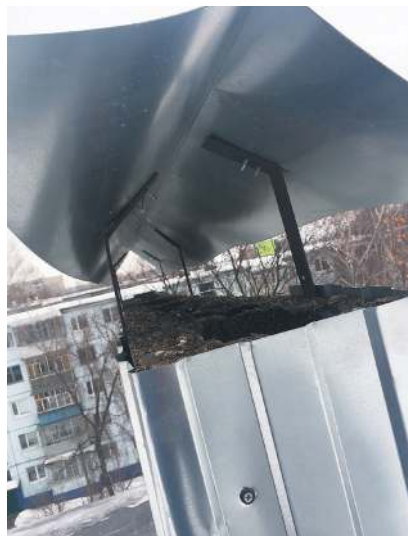
Изначально на вентиляционные каналы установили козырьки из такого тонкого металла, который, как бумага, развеялся на ветру - постоянный лязг не давал спать жильцам
