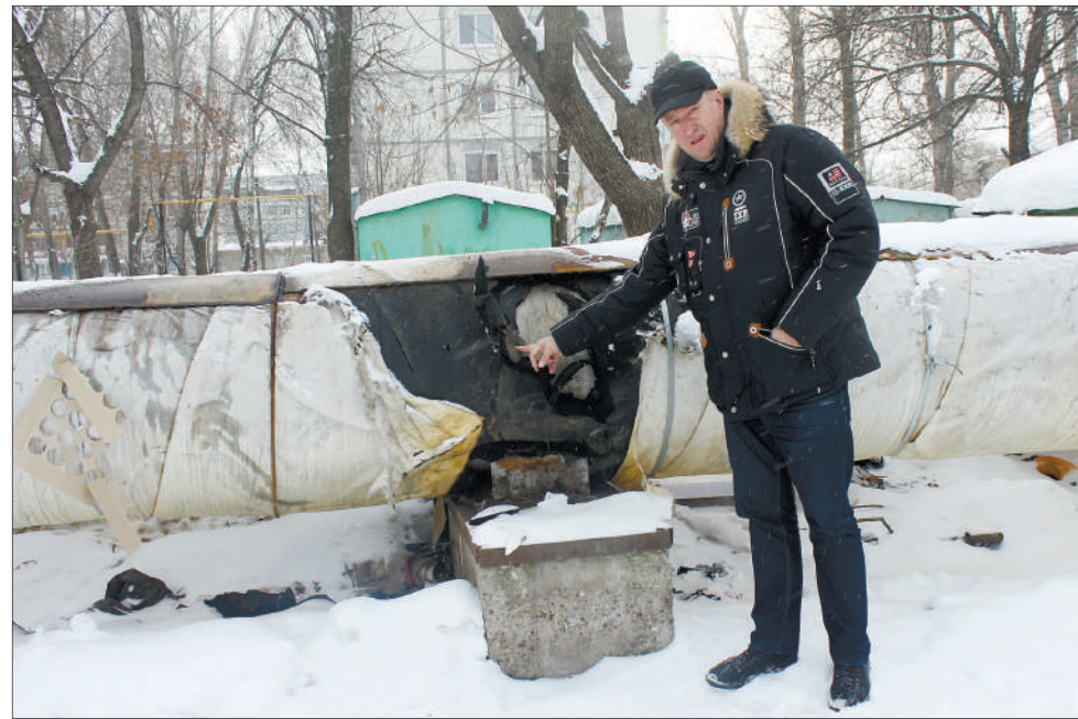
Активисты ОНФ (на фото Алексей СИТНИКОВ) проводили в прошлом году мониторинг «С теплом - труба», который показал, что состояние тепловых сетей в городе оставляет желать лучшего. Большая протяженность изношенных тепловых сетей обуславливает и высокие потери - от 1,73 до 4,77%
